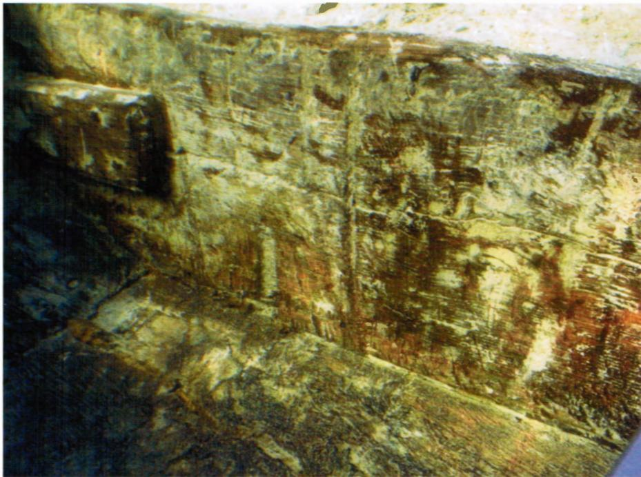
259 ◀ Reichenau-Oberzell. Der Übergang vom Mittel- zum Hecksegment. Unmittelbar über dem Stoß ist auf der Bordwand eine Planke (Auflage für Deck?) aufgedübelt. Am Schiffsboden und im Übergang vom Boden zum Seitenbord ist gelbliche Kalfatmasse zu erkennen.
