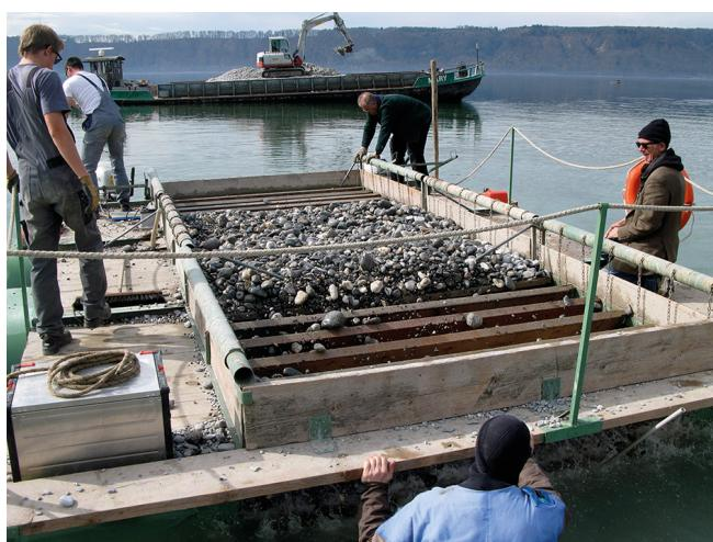
*Abb. 2 - Spezialponton mit zwei geöffneten Segmenten des Jalousienbodens. Im Hintergrund ist mit Minibagger das Kiesschiff (LS Mary) zu sehen. Die Ladekapazität des Pontons erlaubt Kiesabdeckungen bis zu 30 cm Mächtigkeit. Pro Pontonladung können 15,5 m<sup>2</sup> abgedeckt werden. Foto LAD, J. Königinger.*
