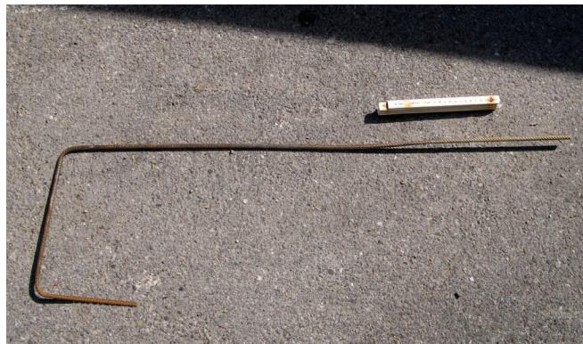
Abb. 4 - U-förmig gebogene Spezialarmier zur Befestigung der Geotextilbahnen am Seegrund. Foto LAD, J. Königner.
