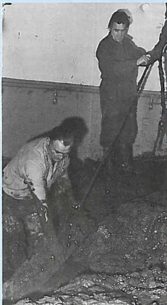
Abb. 18 Bergung eines großen Bauteils des Bremer Wracks von 1380 innerhalb der Taucherglocke der „Carl Straat“ auf dem Grund der Weser.
